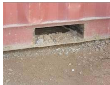
Figure 6.3 - Boue dans un passage de fourches
