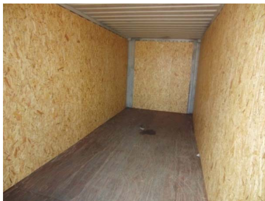
Figure 7.53 - Revêtement d'un conteneur de 40 pieds (12 mètres) à l'aide de panneaux en bois aggloméré
