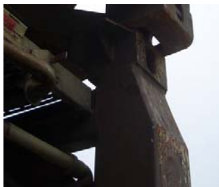
Figure 4.8 - Abaissement au niveau d'une pièce de coin supérieure
