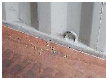
Figure 6.4 - Débris de cargaison antérieure
